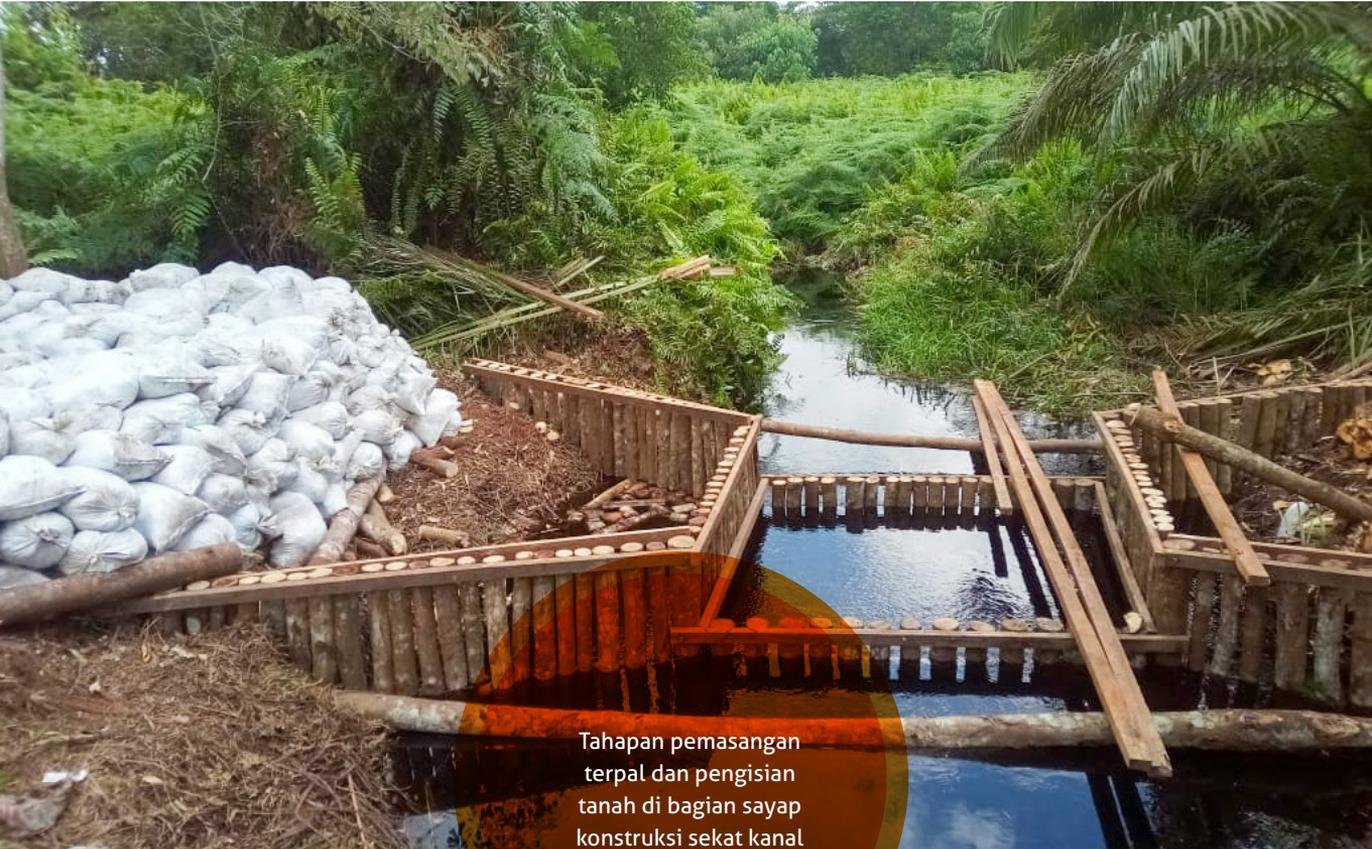
Tahapan pemasangan terpal dan pengisian tanah di bagian sayap konstruksi sekat kanal
