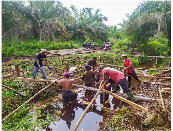
Tahapan pemasangan cerucuk kayu (kayu yang berukuran kecil dan panjang) sebagai pondasi awal konstruksi sayap dan bagian tengah konstruksi sekat kanal
